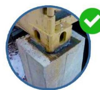
Manera correcta de ocupar el poyo. Contenedor centrado y construido de concreto.
